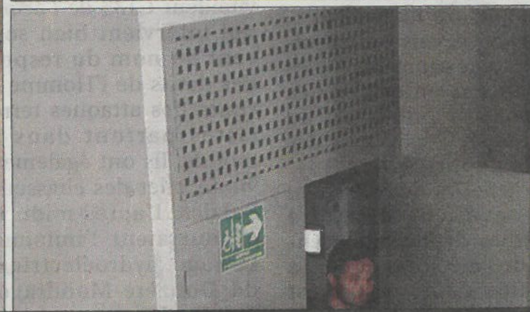
DISCRETION. L'air frais circule dans des conduits larges permettant d'en limiter le bruit, puis est soufflé par des ouvertures ressemblant aux luminaires (photo en haut à droite) et réaspiré au niveau des moucharabieh (comme celui sur la photo en bas à droite).
