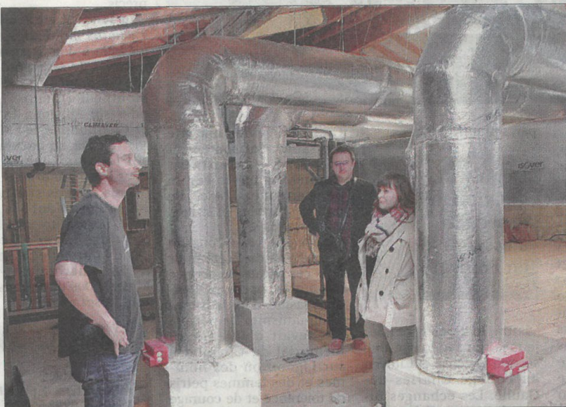
DISCRETION. L'air frais circule dans des conduits larges permettant d'en limiter le bruit, puis est soufflé par des ouvertures ressemblant aux luminaires (photo en haut à droite) et réaspiré au niveau des moucharabieh (comme celui sur la photo en bas à droite).
